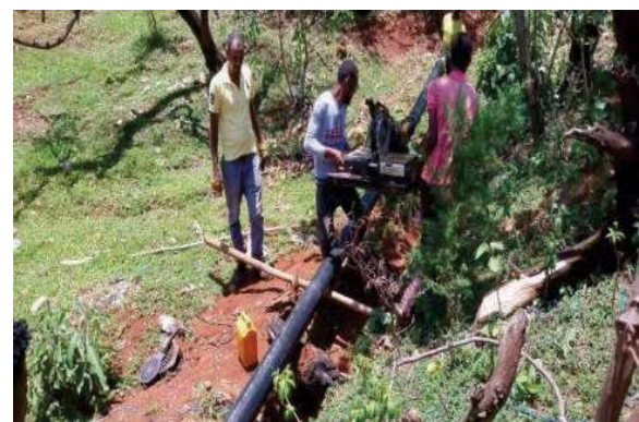
Verlegung PEHD-Leitungsnetz
