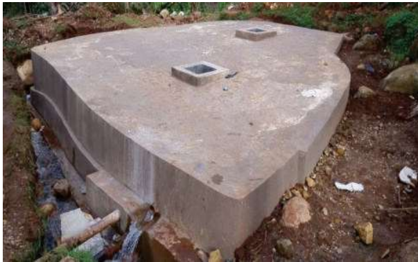
Rehabilitation einer Quelfassung
